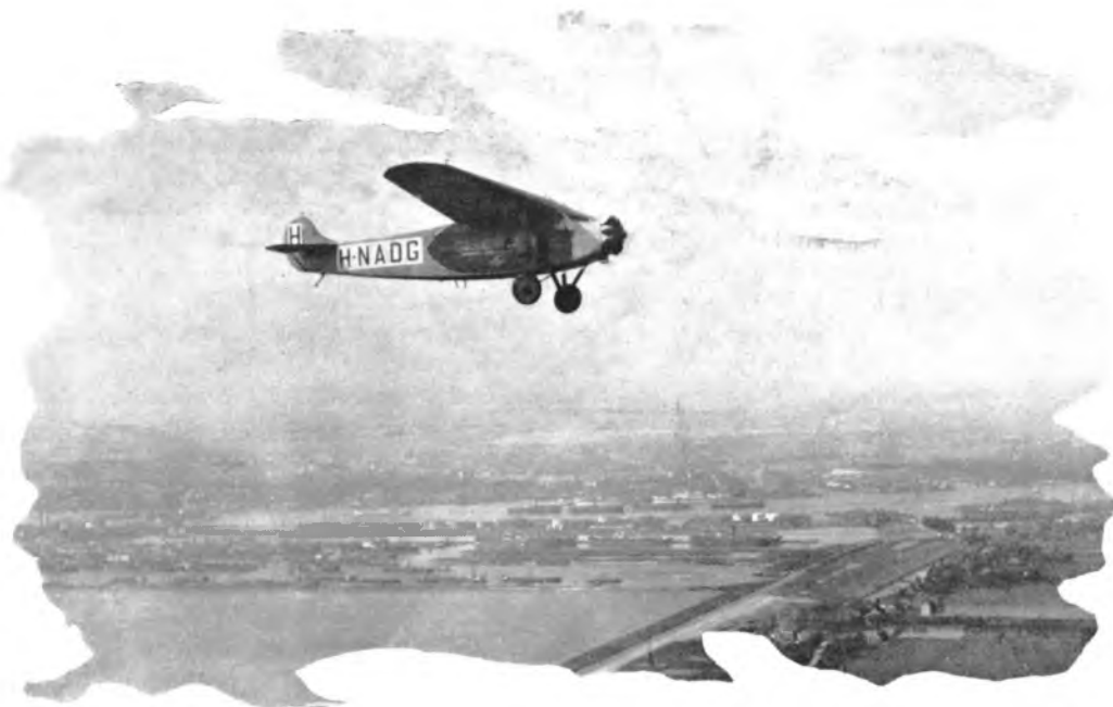
HOLLAND'S TROTS. Een KLM vliegtuig in vlucht. De machine heeft juist Waalhaven verlaten en is in route naar Parijs. Zoodra het luchtvaartuig zich op 400 M. hoogte bevindt, zal de piloot de antenne, die thans nog op een haspel gewonden zit, vieren en daarna het z.g.n. proefsein geven. (Foto Waterstaat)
